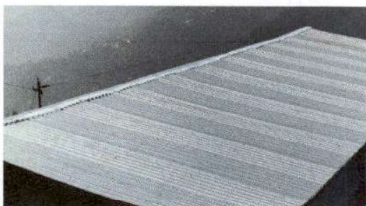
Foto1: Sustrucción de lámina acanalada por lámina troquelada calibre 26 en módulo # 1.
