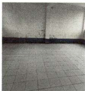
Foto 5: Sustrucción de Piso de torta de cemento por cerámico en módulo # 1 y Pasillo.
