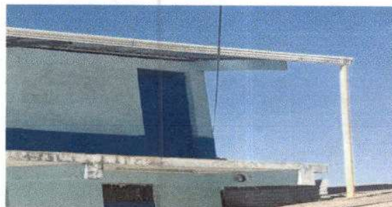
Foto 6: Sustrucción de Bajadas de agua Pluvial de metal por tubo PVC 3".
