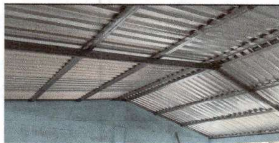
Foto 2: Sustrucción de soporte de madera por metal del módulo # 1.
