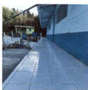
Foto 5: Sustrucción de Piso de torta de cemento por cerámico en módulo # 1 y Pasillo.
